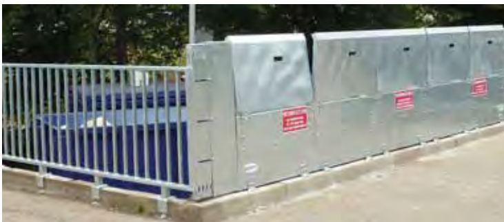
▼ Garde-corps fixe et barreaudages verticaux sur les bennes des encombrants
